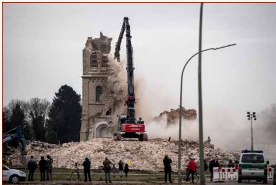
Chiesa in fase di demolizione in Germania
